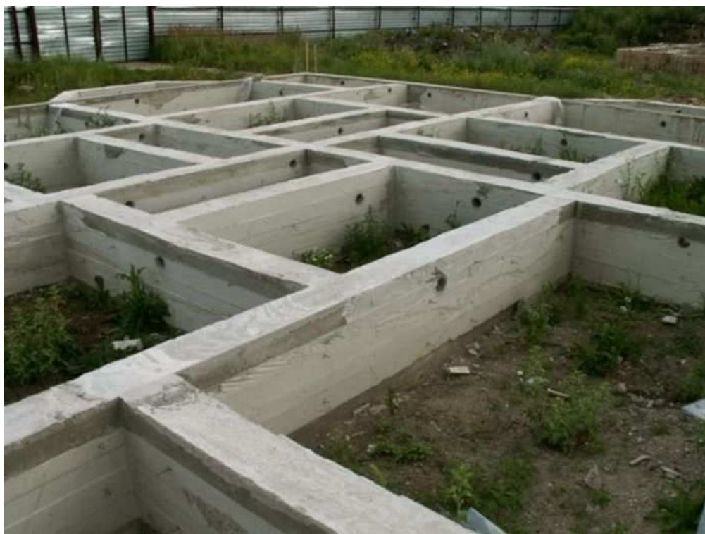
Рис. 13. Пример ленточного фундамента
