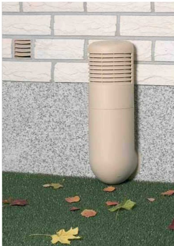
Рис. 24. Пример вентиляции цоколя
