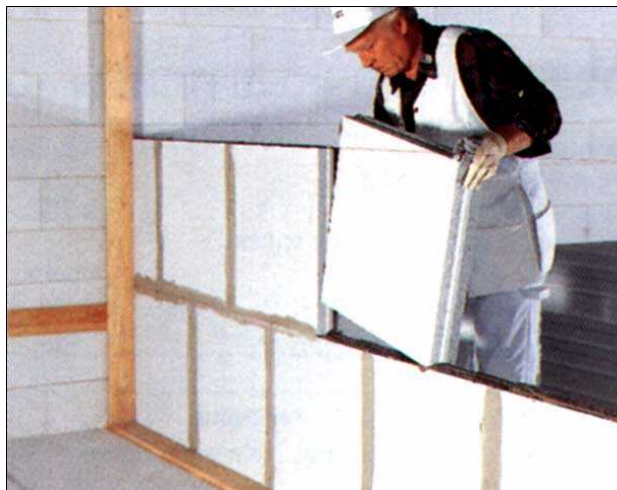
Рис. 49. Перегородка из гипсовых плит
