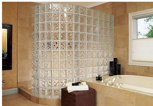
Рис. 49. Перегородка из стеклоблоков
