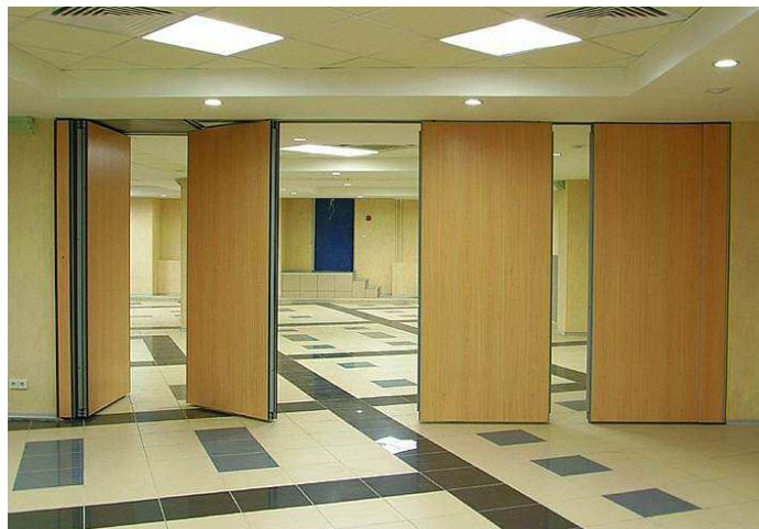
Рис. 56. Внешний вид раздвижной перегородки
