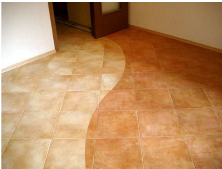
Рис. 70. Полы из керамических плит
