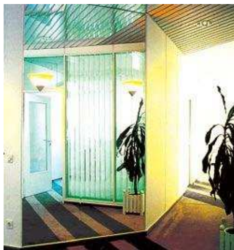
Рис. 50. Перегородка из стеклопрофилита
