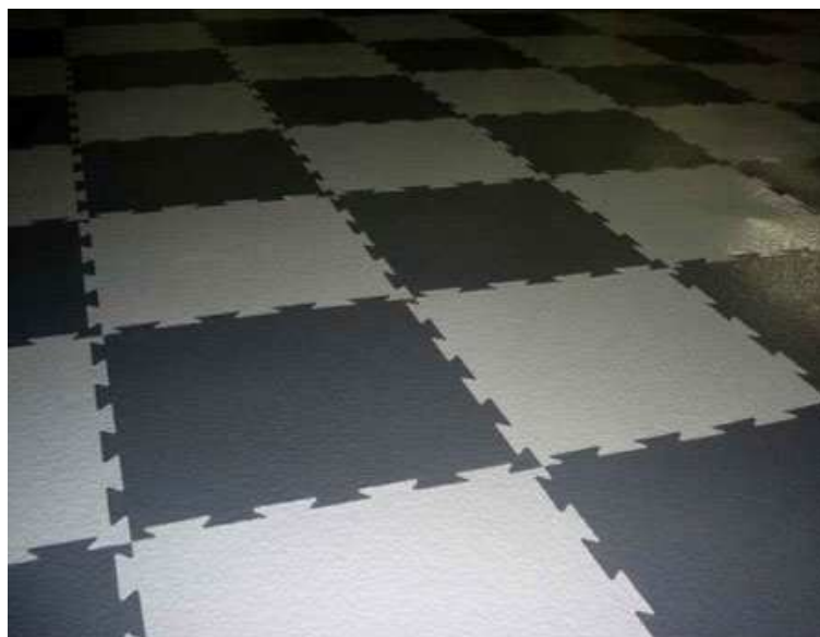
Рис. 69. Полы из поливинилхлоридных плит
